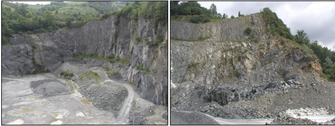
Figura 13. Taludes de huecos excavados en rocas duras con distinto grado de fracturación y alteración
