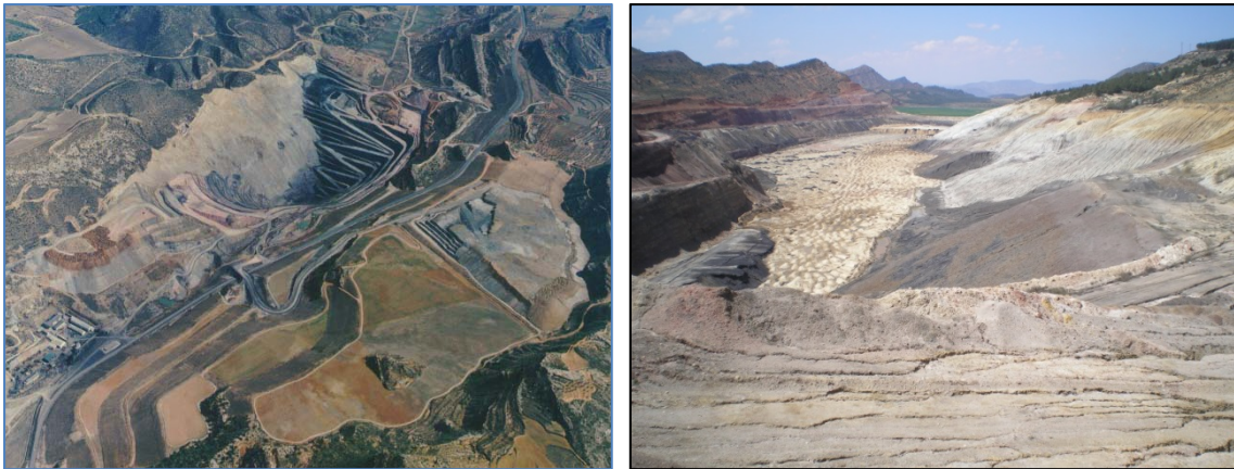
Figura 2. Minería de transferencia y relleno final del hueco residual con yesos de desulfuración en la Corta Barrabasa (Andorra, Teruel) (ENDESA GENERACIÓN, SA)
